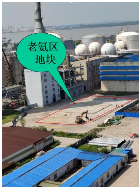
图 2-2 新浦化学原氨罐区拆除完成后现场照片
