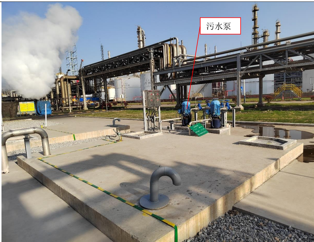
新建配套污水池
