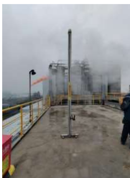
A6 滚筒添加系统废气排气筒
