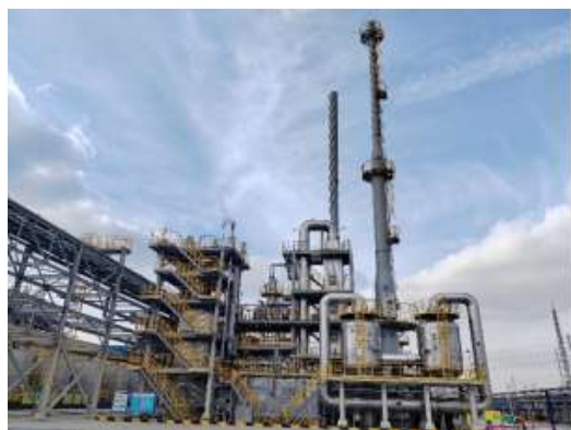
二噁英吸附装置和SCR反应器
