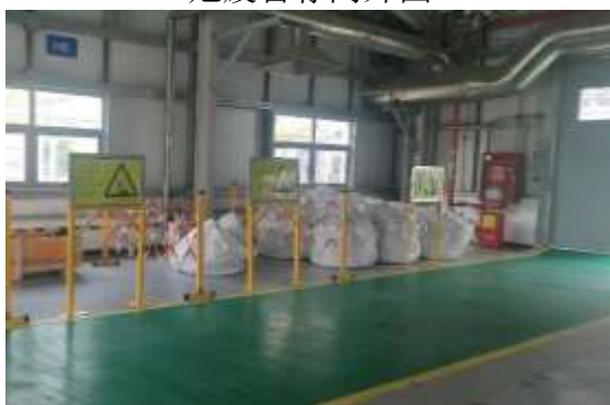
危废暂存间内部
