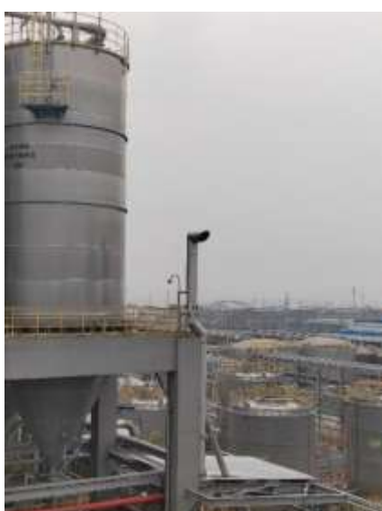
A7 包装废气及气力输送废气排气筒
